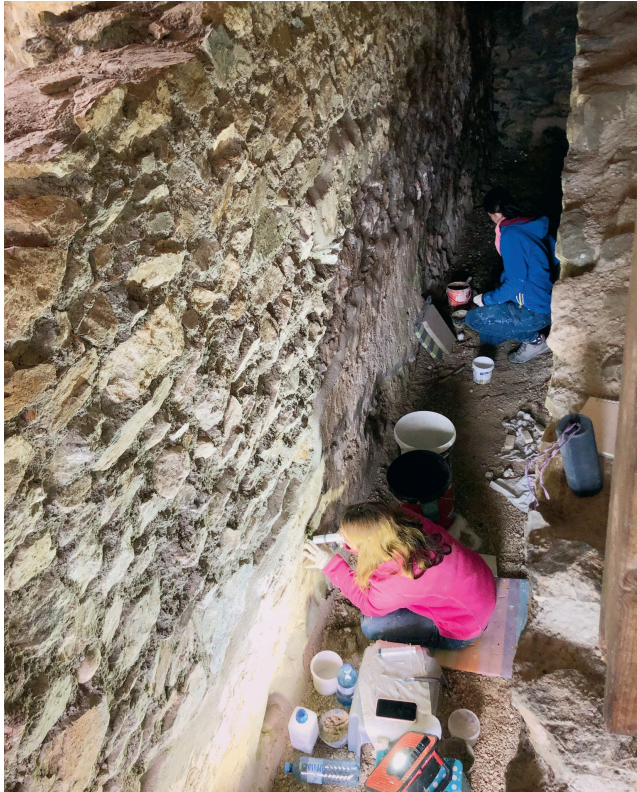
Abb. 10: Arbeitssituation in Raum AA46, Hinterfüllung von Putzhohllagen und Kittung der Ränder
