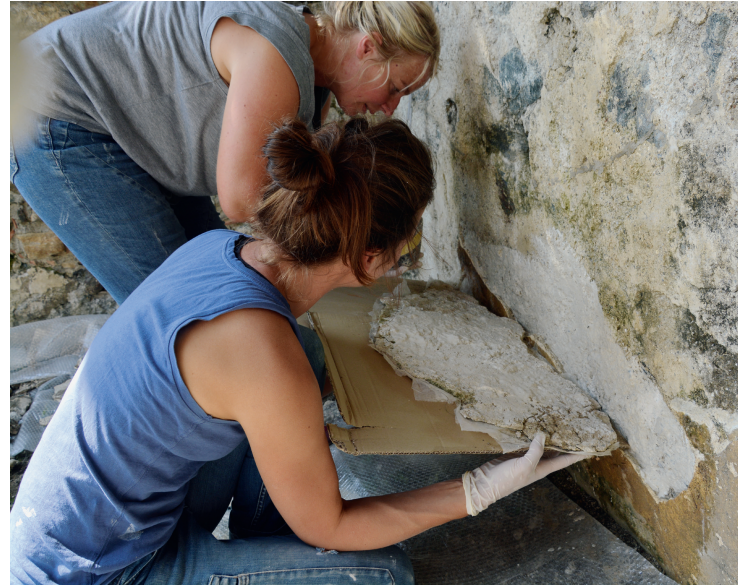
Abb. 11: Arbeitssituation in Raum AA36, Wiederversetzen von römzeitlichen Putzfragmenten
