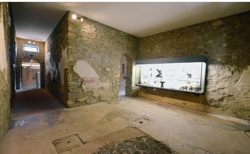
Abb. 4: Raum D, Vorraum zur Therme, Blick nach SO
