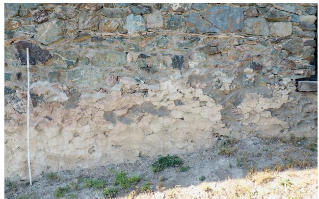
Abb. 3: SH 8, Anhand des Brandhorizonts ist das ehemalige Bodenniveau des Raums zu erkennen
